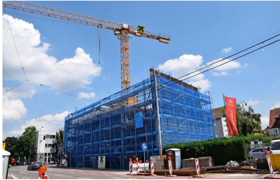
Das Bauunternehmen Amos aus Brackenheim ist in der Region sehr aktiv. Im Bild die aktuelle Baustelle des neuen Autohauses in der Heilbronner Südstraße. Foto: Amos
