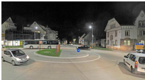
Die drei Kreisverkehre – hier die Anlage am Brackensteiner Jugendhaus – haben einen Durchmesser von jeweils 30 Metern.
