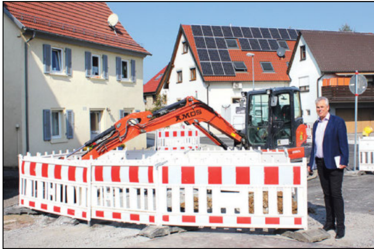
Tiefbauamtsleiter Erich Haffelder freut sich, dass der erste Bauabschnitt in Obergimpfern abgeschlossen ist. Foto: Falk-Stéphane Dezort
