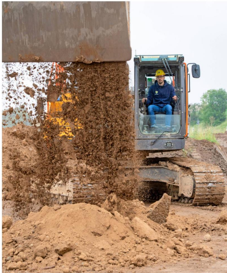
Auf ungewohnter Position: Der Mannheimer Rechtsaußen Patrick Groetzki hat als Praktikant für einen Tag auf einer Großbaustelle in Massenbachhausen mit angepackt.
