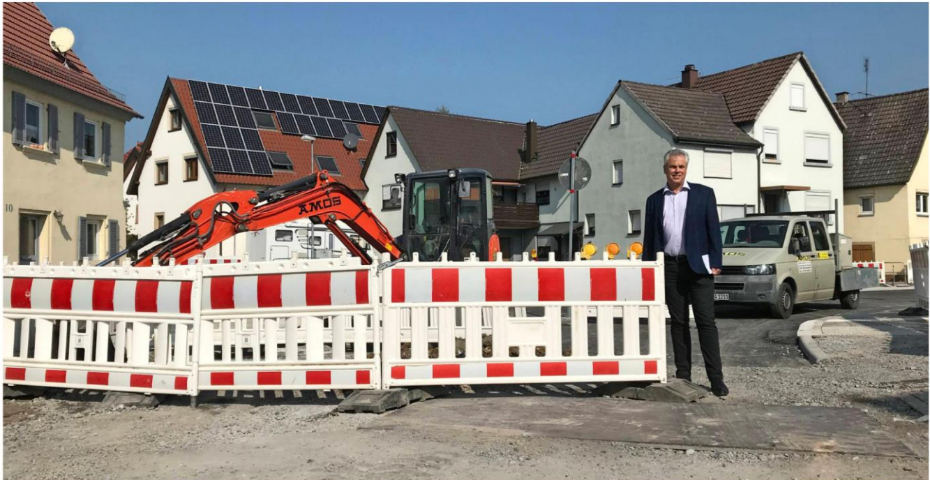
Der zweite Bauabschnitt in der Grombacher Straße hat am 21. September begonnen. Bis November 2021 soll laut Erich Haffelder die Sanierung beendet sein.
