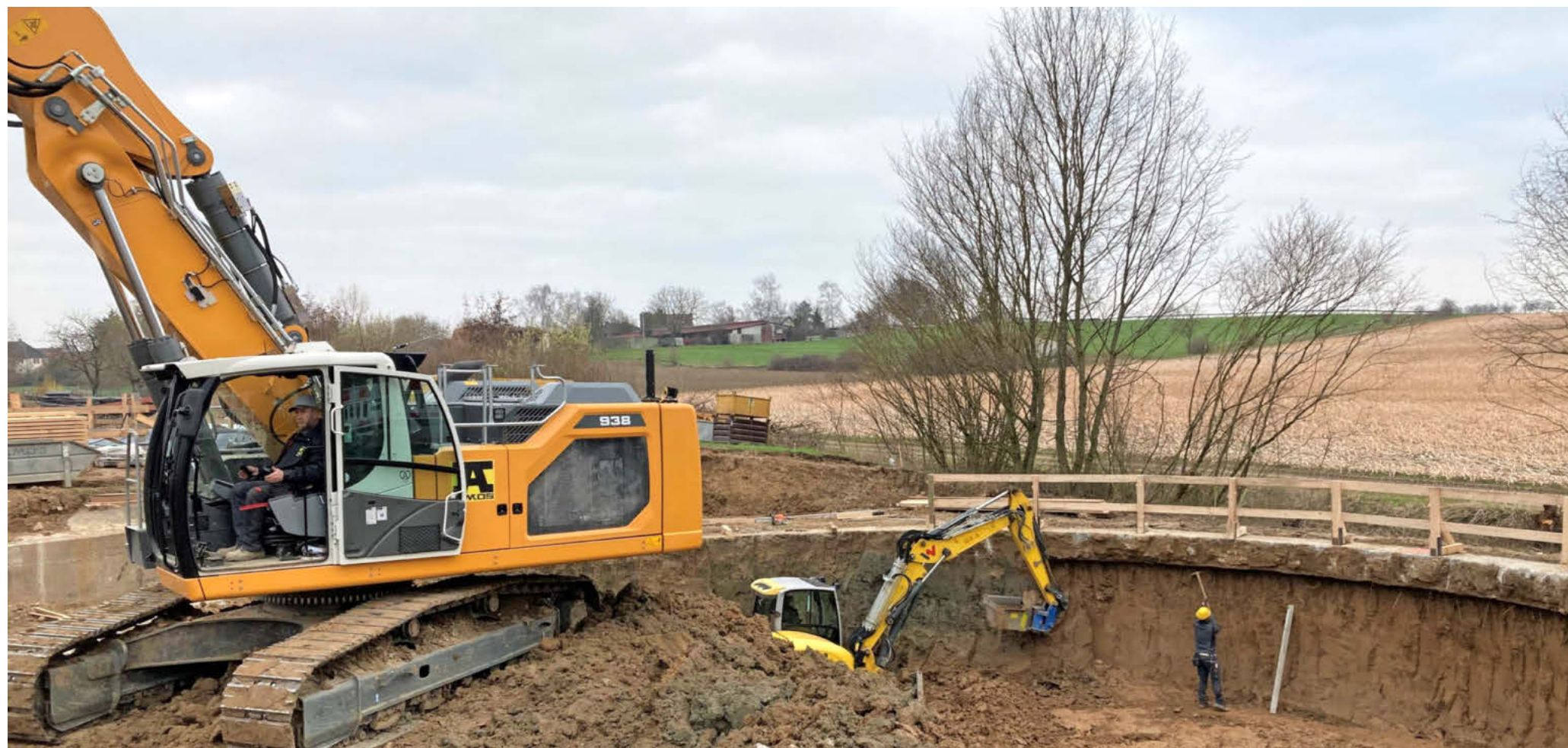
Das neue Regenüberlaufbecken zwischen Siegelsbach und Zimmerhof wird insgesamt neun Meter tief und hat einen Durchmesser von 17,5 Metern.
