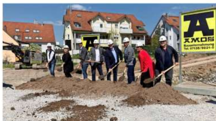
In den nächsten Monaten wird ein neues Pflegeheim vom Haus zum Fels in der Ortsmitte aus dem Boden wachsen.
