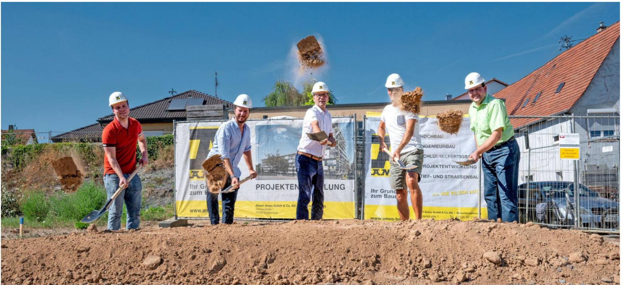
Nach sechs Jahren kann es losgehen: Das Mehrfamilienhaus, das die Firma Amos in der Lauffener Straße 7-11 baut, soll Mitte/Ende 2024 fertiggestellt werden.
