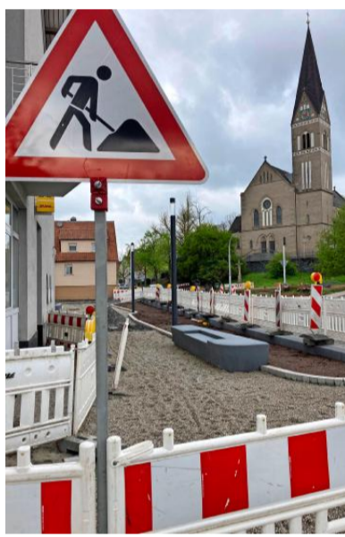
Bis Ende Mai soll auch der Rathausvorplatz als Begegnungsort fertig sein.
