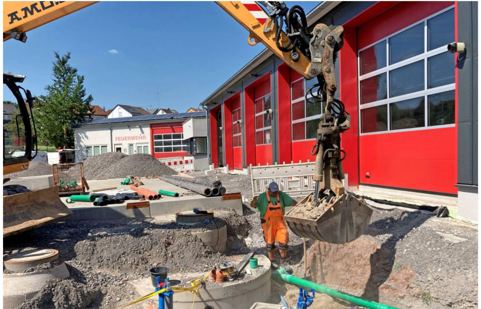
Auf dem Baustellenareal des Feuerwehrmagazins wurden schon im August Leitungen verlegt und angeschlossen.
