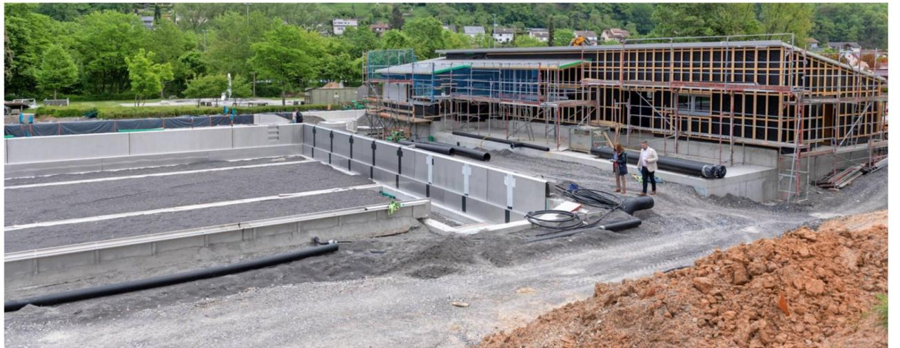
Die 50-Meter-Bahnen des Sportbeckens sind mit Wasserleitungen durchzogen und verfüllt. Der Edelstahlboden fehlt noch. Im Hintergrund das neue Technikgebäude.
