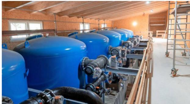
3,5 Tonnen schwer ist jeder der sechs Filterkessel, die im Technikgebäude bereits aufgestellt sind und in denen das Wasser aufbereitet wird.
